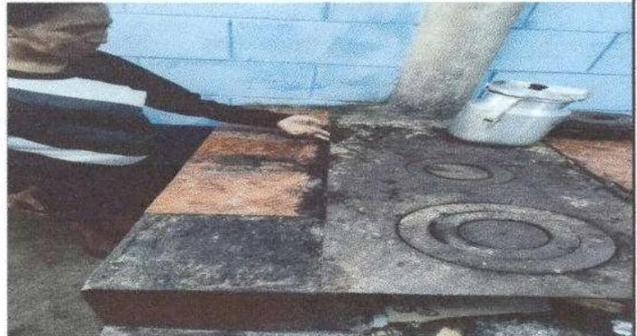
Foto8 : Sustitucion de Estufa Rural Copleta (Incuye Chimenea y Plancha de Metal) Se complementara con otra Mas.
